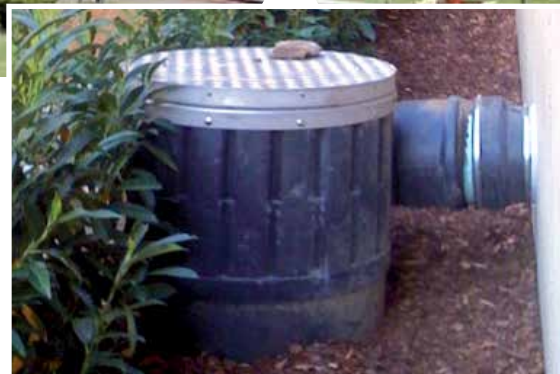
Der Wirbel-Feinfilter WFF 300. Der Zulauf des Regenwassers erfolgt oberirdisch direkt aus der Wand des Gebäudes heraus. Die Abläufe für das gefilterte Wasser und das Restwasser verlaufen unterirdisch.
